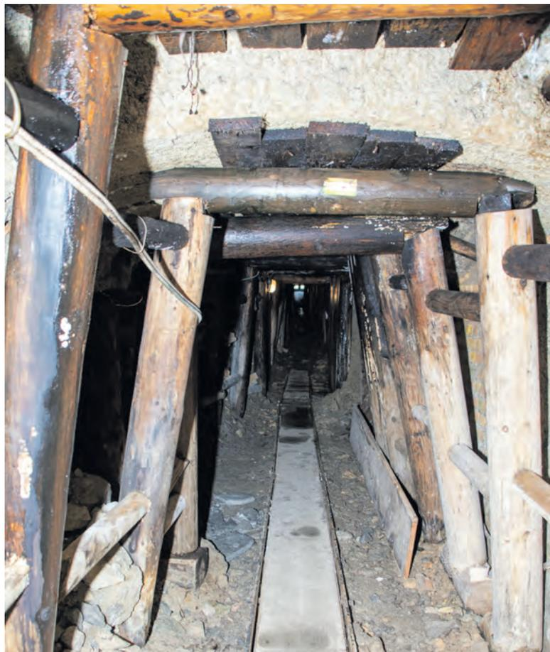
Mit mächtig dimensionierten Rundhölzern wird der Stollen im Berg abgestützt.
