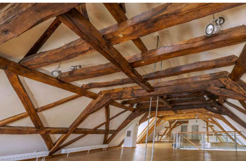
Der Dachstuhl ist gemäss dendrochronologischer Untersuchungen im Jahr 1544 entstanden.
