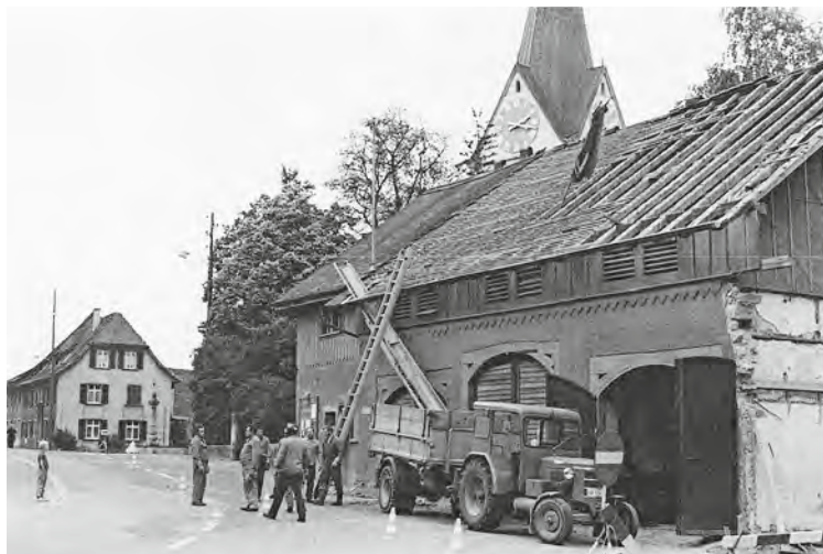
Auf dem Kirchplatz wird 1972 das alte Feuerwehrmagazin abgerissen.
